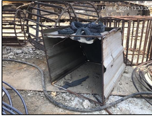
รูปที่ 59 ที่กำบังสะเก็ดไฟ กรณีที่มีการเชื่อมต่อโลหะในพื้นที่ก่อสร้าง
