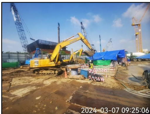
รูปที่ 39 ขุดลอกตะกอนที่สะสมในบ่อดักขยะและดักตะกอนดิน
