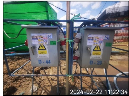
รูปที่ 56 ตู้จ่ายไฟฟ้า
