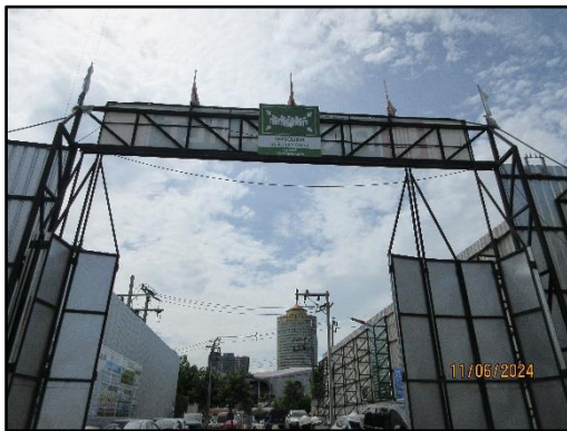
รูปที่ 59 ที่กำบังสะเก็ดไฟ กรณีที่มีการเชื่อมต่อโลหะในพื้นที่ก่อสร้าง
