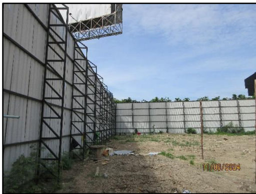
รูปที่ 7 รั้ว Mesh Sheet บริเวณโดยรอบแนวการก่อสร้าง/รื้อถอนโครงการ
