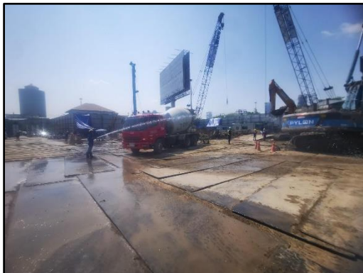
รูปที่ 14 ฉีดพรมน้ำบริเวณพื้นที่ก่อสร้างหรือบริเวณที่ทำให้เกิดฝุ่น
