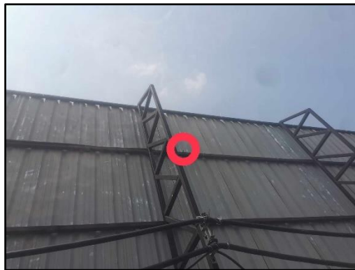
รูปที่ 16 ม่านละอองน้ำ บริเวณรั้ว Mesh Sheet รอบโครงการ
