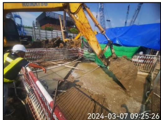
รูปที่ 39 ขุดลอกตะกอนที่สะสมในบ่อดักขยะและดักตะกอนดิน
