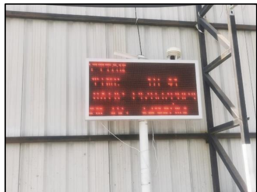
รูปที่ 17 ระบบตรวจสอบคุณภาพสิ่งแวดล้อมแบบเรียลไทม์ผ่านจอแสดงผล
