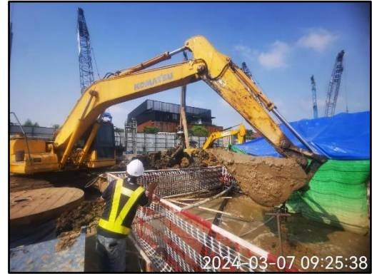
รูปที่ 39 (ต่อ) ขุดลอกตะกอนที่สะสมในบ่อดักขยะและดักตะกอนดิน
