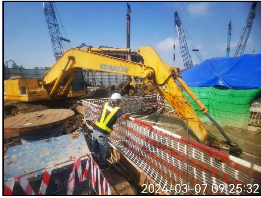
รูปที่ 39 (ต่อ) ขุดลอกตะกอนที่สะสมในบ่อดักขยะและดักตะกอนดิน
