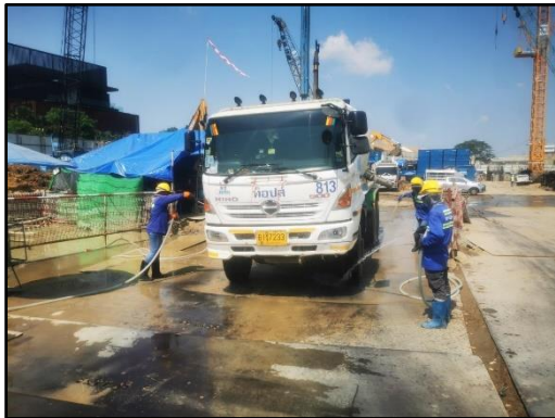
รูปที่ 21 คนงานล้างล้อรถ
