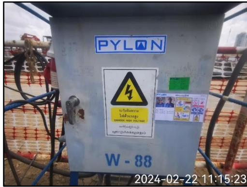
รูปที่ 56 ตู้จ่ายไฟฟ้า
