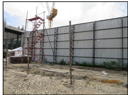
รูปที่ 7 รั้ว Mesh Sheet บริเวณโดยรอบแนวการก่อสร้าง/รื้อถอนโครงการ
