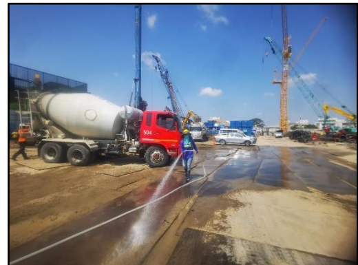
รูปที่ 14 ฉีดพรมน้ำบริเวณพื้นที่ก่อสร้างหรือบริเวณที่ทำให้เกิดฝุ่น
